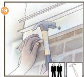
Befestigen Sie das Mauerprofil mit Schrauben an der Wand (2 Personen). Die Schrauben mit einem Hammer teilweise in die Befestigungslöcher schlagen und das letzte Stück der Schraube in die Wand drehen.
