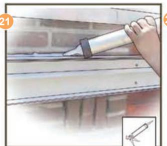
Spritzen Sie die Fuge zwischen Wand und Wandprofil mit Silikon dicht.
