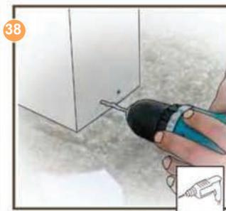
Bohren Sie zwei Befestigungslöcher in die Pfosten (für jede Verbindungsecke vor). Schrauben Sie den Pfosten auf den Verbindungssecken mit den Schrauben fest. Drücken Sie die Abdeckkappe auf die Schrauben.
