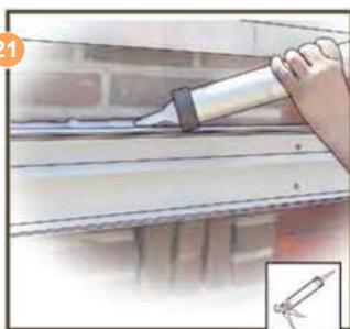
21 Kit de naad tussen de muur en het muurprofiel met siliconenkit dicht.
