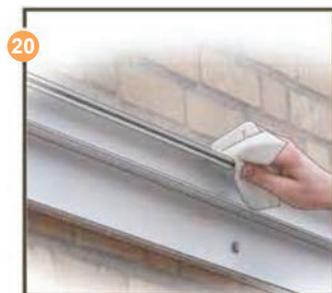
Dégraissez le profil mural sur la face supérieure proche du mur.
