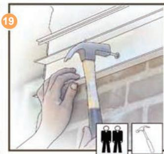
19 Zet het muurprofiel vast op de muur met de nagelpluggen. (2 personen) Sla de nagelpluggen met een hamer in de bevestigingsgaten. Schroef het laatste stuk van de nagelpluggen in de muur.
