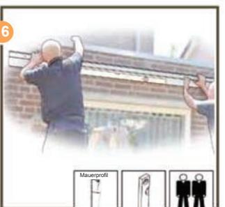
Halten Sie das Wandprofil gegen die Wand, damit die Befestigungslöcher in die Wand gebohrt werden können (2 Personen). Halten Sie das Wandprofil im Blei und ziehen Sie dieses auf die Wand.
