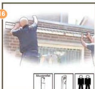
Houd het muurprofiel tegen de muur zodat de bevestigingsgaten in de stenen geboord kunnen worden. (2 personen) Houd het muurprofiel waterpas. Tek en het muurprofiel af op de muur.
